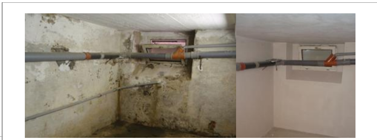
Obrázek č. 1-Sanace sklepa ÚMČ Praha 21
