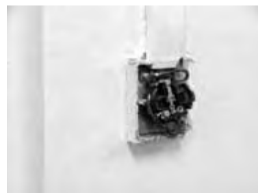
rozbitý vypínač světel - šatna
