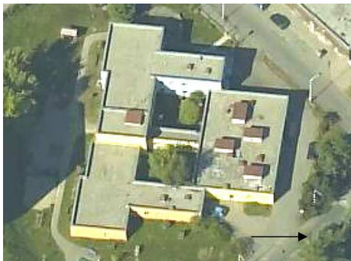
Situační půdorysný pohled na střechy objektu (sever vpravo)
